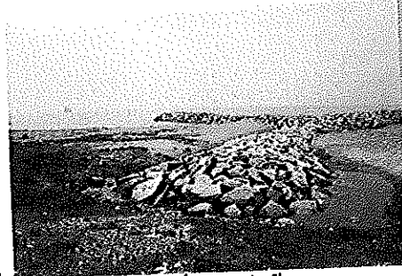
4. รอดรูปตัว Y ในที่สุดจะเต็มไปด้วยตะกอน
