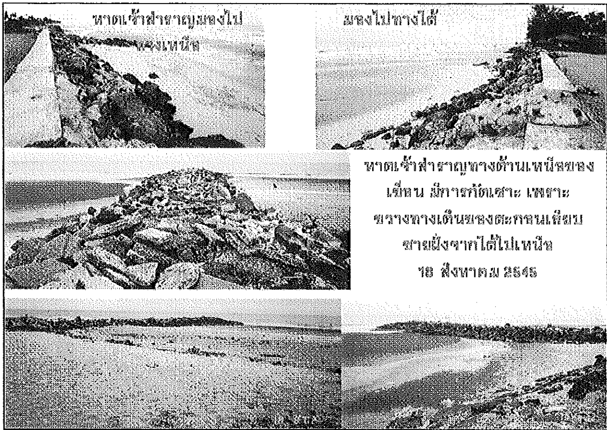
ภาพที่ ๕๐ เขื่อนรักษาร่องน้ำที่ชะอำก่อให้เกิดการเปลี่ยนแปลงของงบประมาณตะกอน (อัครสุดาถ่ายภาพ)
