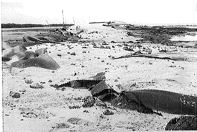
ภาพที่ 55 ไส้กรอกทรายแตกพ่นทรายมาบนหาดเลน ไม่ได้ชะลอคลื่นมากนัก (วรพล ดวงล้อมจันทร์ ถ่ายภาพ)
