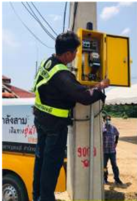
งานซ่อมแซมไฟฟ้าแสงสว่าง
