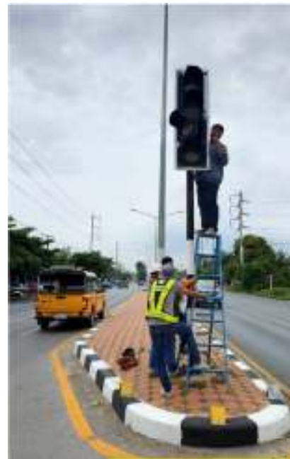
งานซ่อมแซมสัญญาณไฟจราจร
