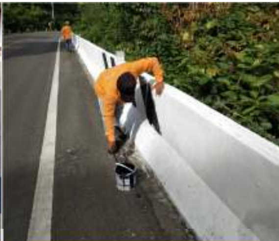
งานทาสีแบรีเออร์คอนกรีต
